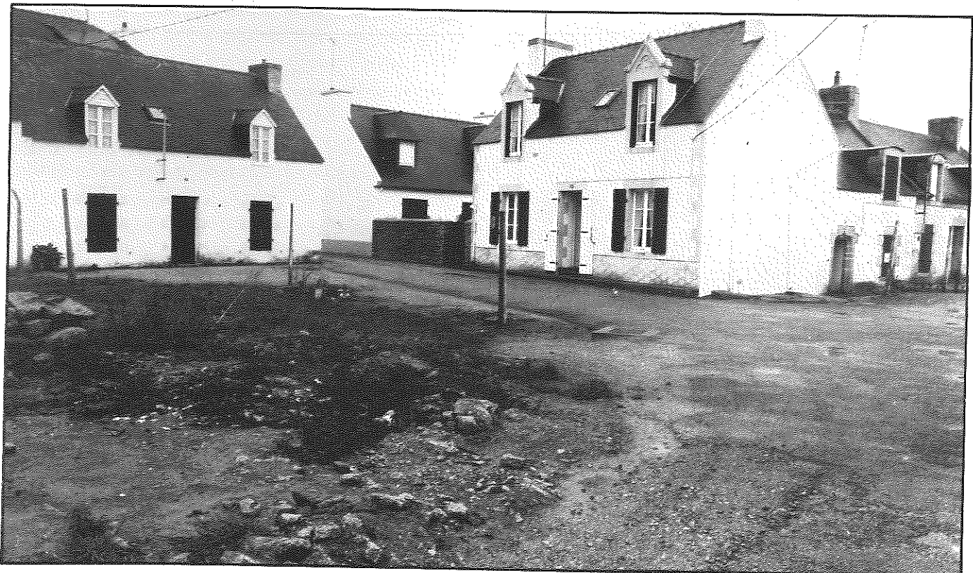
Aire de Ruhaor. La structure ancienne s'observe encore aujourd'hui avec ses maisons disposées autour de l'aire à battre ou leurquer.
