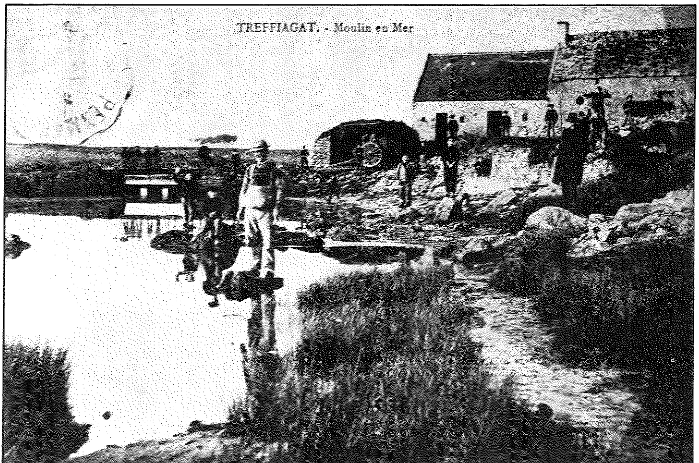
"Ar Veil Vour" (Moulin en mer) vers 1910. La petite fermette existe encore aujourd'hui, restaurée dans sa configuration originale. On distingue nettement les vannes qui, à marée haute, empêchaient la mer d'inonder la vallée en amont du pont. Le pont marquait la limite des deux communes du Guilvinec et de Treffiatag.
